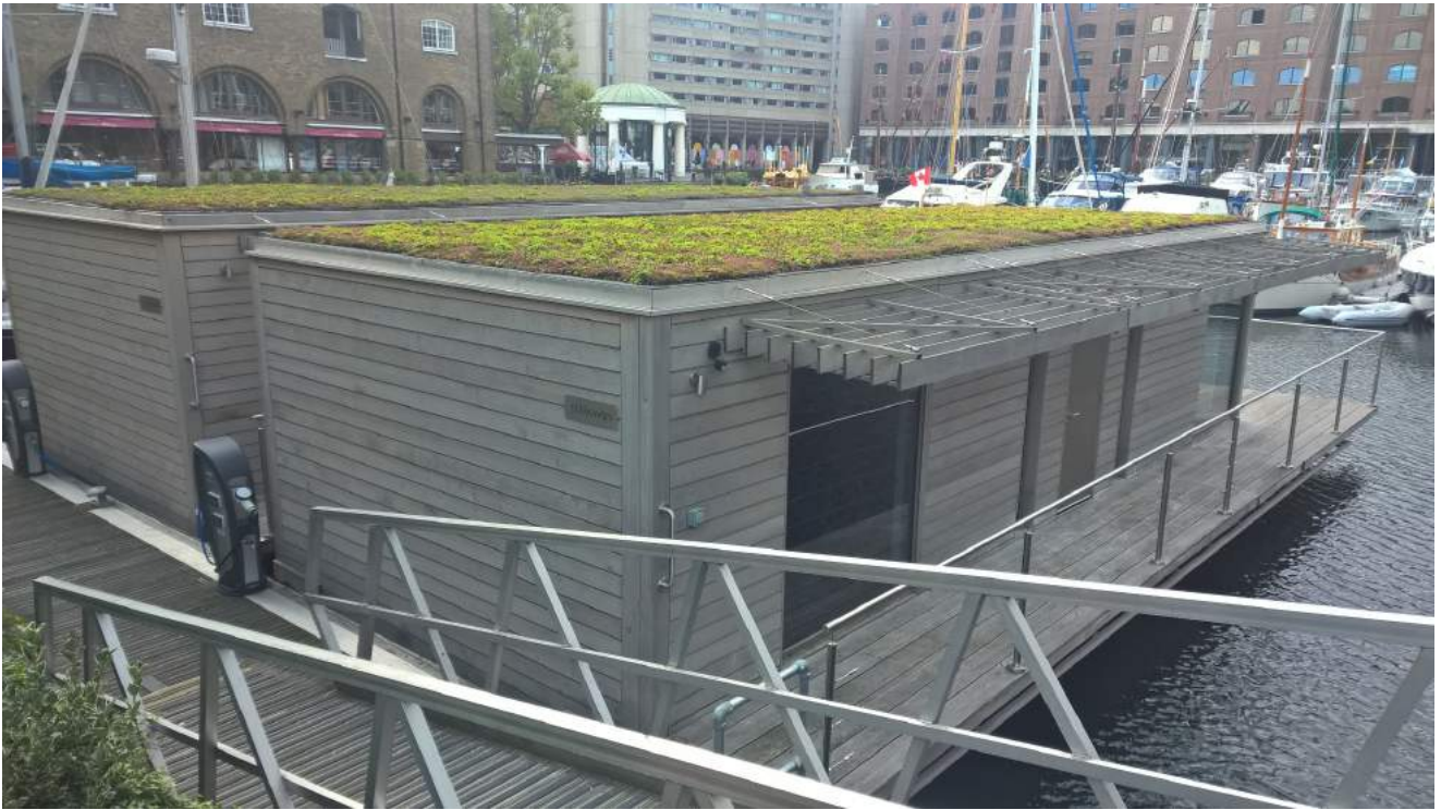
Coperture verdi alla St. Katharine Docks Marina
