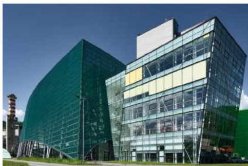
Impianto di Termovalorizzazione, Bolzano
