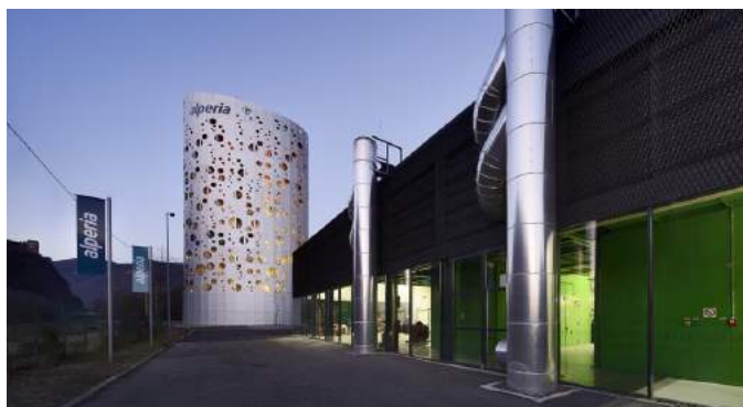
Centrale di teleriscaldamento Alperia, Quartiere Casanova
