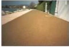
Elemento ecocompatibile, stabilizzante e consolidante dei terreni, costituito da ossidi inorganici selezionati e fibre polimeriche inerti. Lo stabilizzante ha un impatto ambientale trascurabile se paragonato al consolidamento tradizionale realizzato con l'impiego di un conglomerato cementizio, costituito da inerti e cemento o calce e con l'eventuale applicazione di un manto di asfalto.
